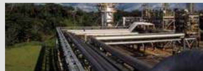
GASODUTO URUCU-COARI-MANAUS (AMAZONAS)
