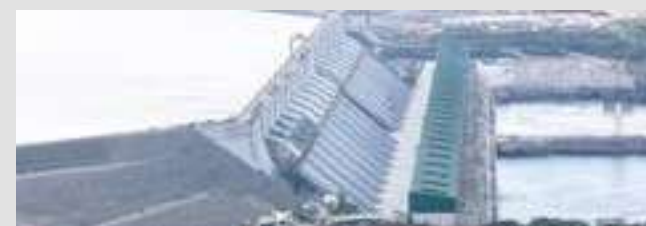
HIDRELÉTRICA DE BELO MONTE (PARÁ)
