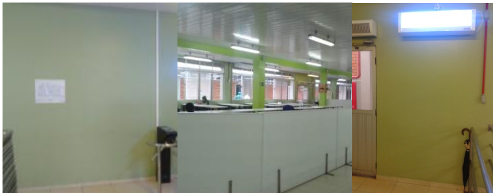
Figura 4 Locais de futuras intervenções: Paredes que receberão painéis e divisórias que serão substituídas por divisórias de paletes.
