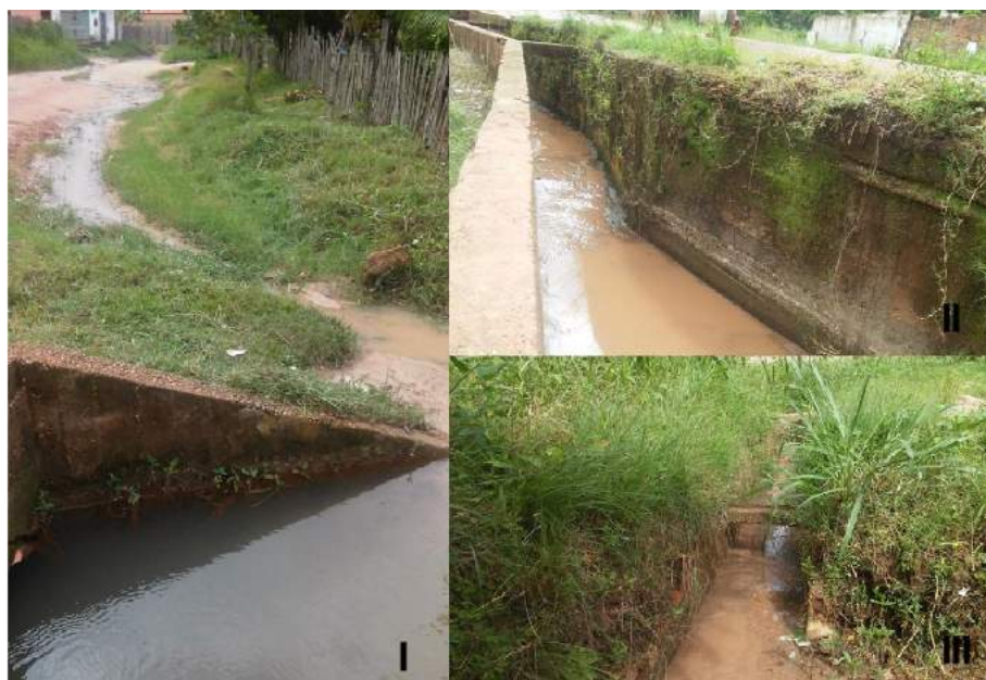
Figura 4: I , II e III - Lançamento do esgoto próximo ao Igarapé, no bairro Patauateua.
