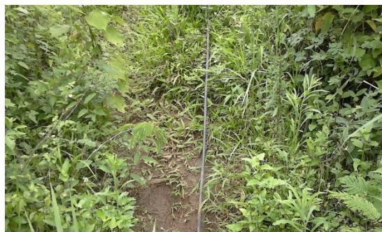
Figura 4: instalação de encanamento para abastecimento dos tanques no ponto P1.
